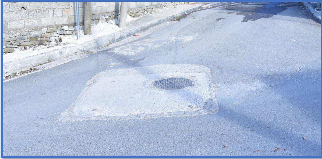
Fig. 4 Pavaresisht rikonstruksionit rishtaz te rruges, nderhyrjet per riparime jane te shpeshta dhe te papershtatshme per lidhjen koherente te shtresave te riparuaruara me ato ekzistente (beton/asfalt)
