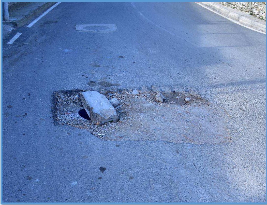
Fig. 3 Pavaresisht se rikonstruksioni i rruges eshte i sapo perfunduar, verehen demtime te rend ate saj, dhe mungese riparimi te tyre
