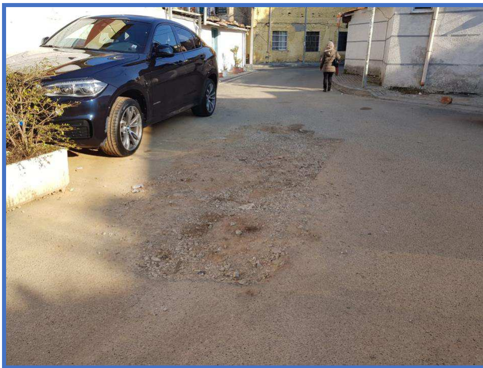
Fig. 4 Shtresat asfaltike kane pesuar demtime te thella per shkak te nderhyrjeve ne trupin e rruges. Keto demtime nuk jane riparuar, pavaresisht qenies se ketij investimi brenda afatit te garancise se punimeve.
